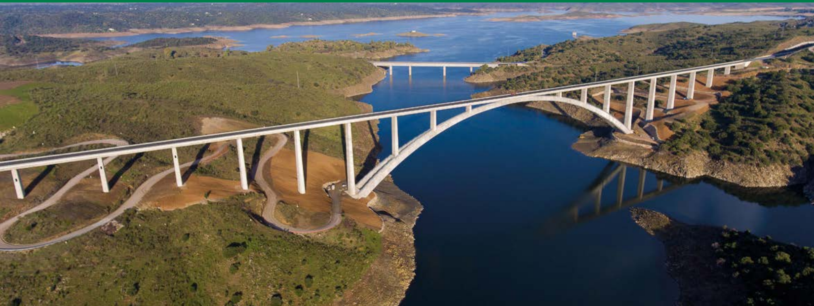
AVE Madrid-Extremadura Tramo embalse de Alcántara – Garrovilla. Área I, Gerencia Convensa.
