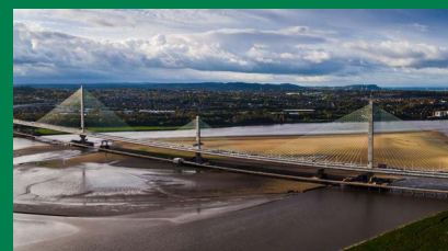
Puente de Mersey Área II, Gerencia Reino Unido-Irlanda.
